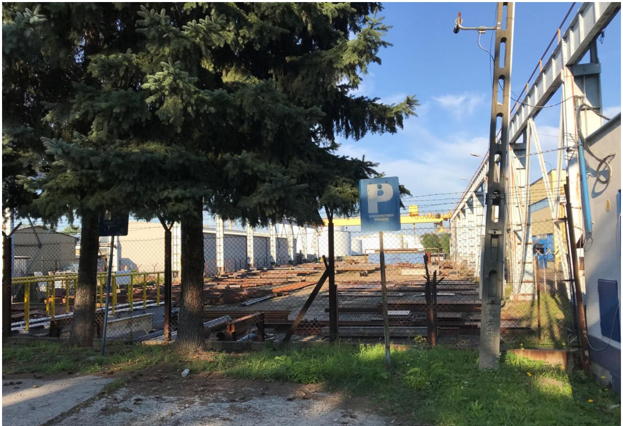
Fot. Widok w kierunku wschodnim z ul. Niegłowskiej w na teren objęty opracowaniem w rejonie jego północno-zachodniego narożnika.
