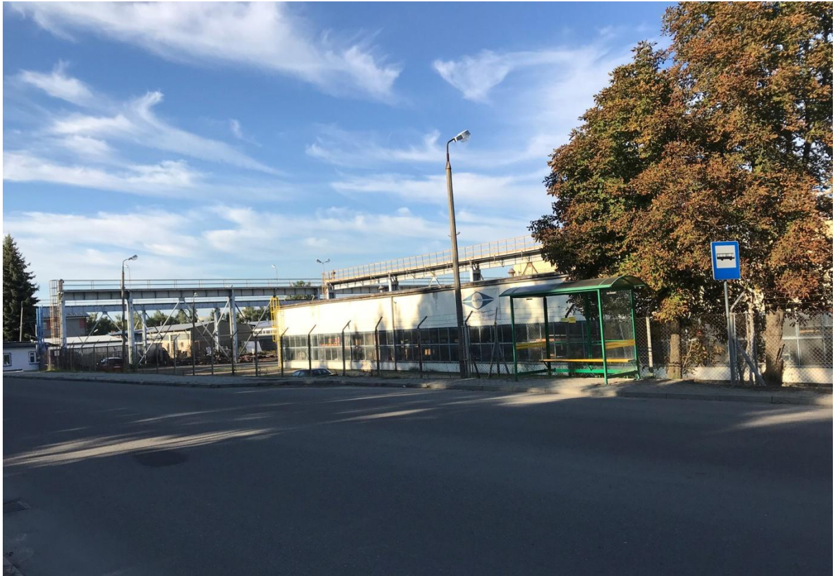
Fot. Widok w kierunku północno-wschodnim z ul. Niegłowickiej na teren objęty opracowaniem.
