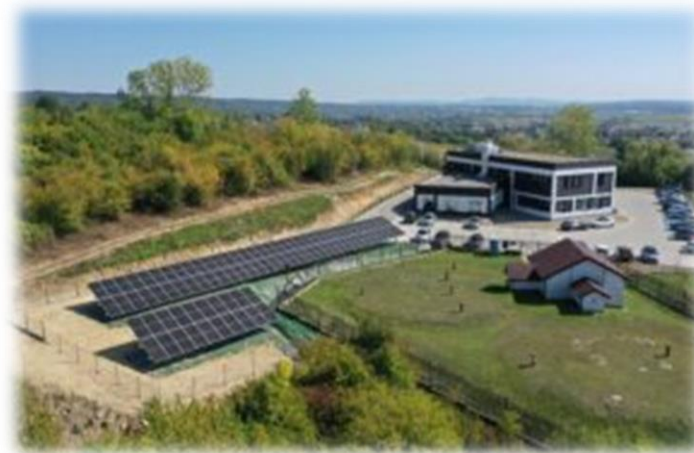
Nowy budynek administracyjny przy ulicy Na Kotlinę 33.
