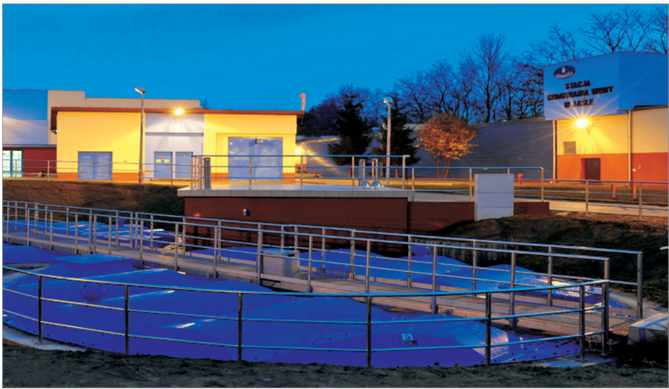
Stacja Uzdatniania Wody (fot. ze zbiorów MPGK Sp. z o.o.)
