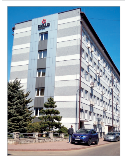
EXALO Drilling S.A. (fot. ze zbiorów UMJ)
