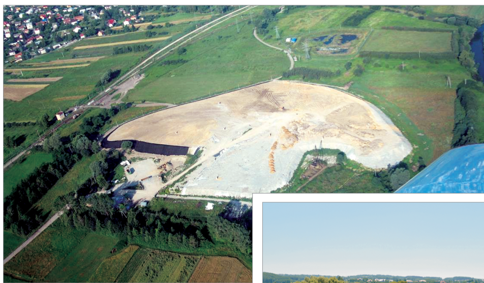
W trakcie rekultywacji
